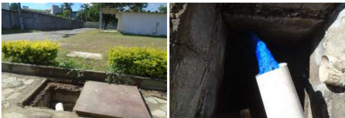
Figura 122: Interligação Cenário Hall à rede interna de coleta - caixa de passagem/ teste de corante
